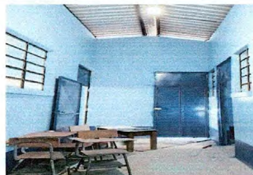
FOTO 8: SUSTITUCIÓN DE LÁMPARAS
