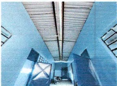
FOTO 1: SUSTITUCIÓN DE CAPOTE DE LÁMINA
