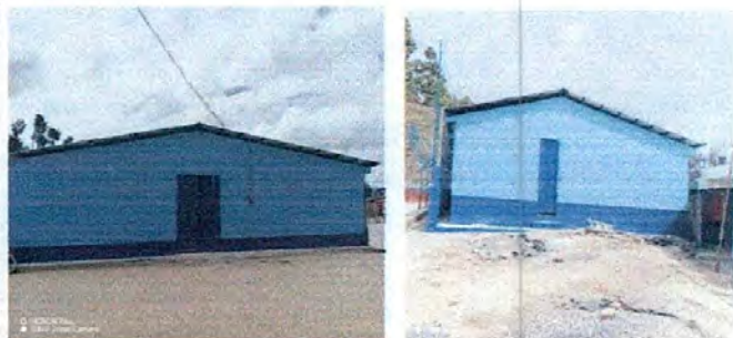
FOTO 11: MANTENIMIENTO DE PARED Y PINTURA
