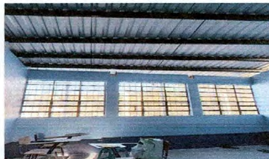
FOTO 2: SUSTITUCIÓN DE LÁMINA
