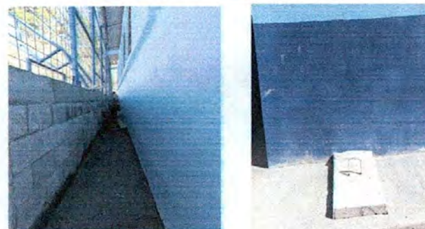
FOTO 12: REPARACIÓN DE BANQUETA DE CONCRETO
