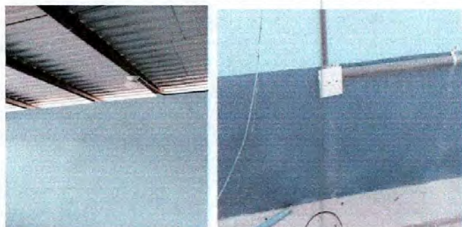
FOTO 7: REPARACIÓN DE SISTEMA ELÉCTRICO
