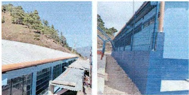
FOTO 13: SUSTITUCIÓN DE CANALES Y BAJADA DE AGUA PLUVIAL DE METAL POR TUBO
